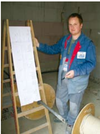
Auch im Innern des Gebäudes gehen die Arbeiten voran.
