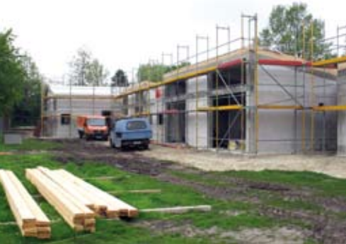
Der Kita-Bau nimmt Form an. Hier sollen ab Oktober 70 Kinder toben und spielen.
