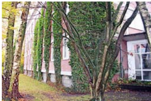
Jetzt aufwendig saniert: H-Trakt der Wohnanlage Huntemannstraße
